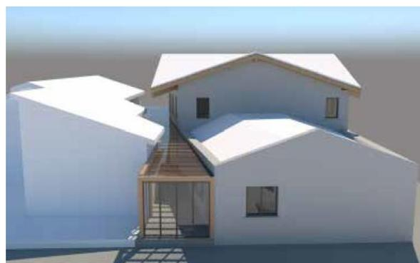
L'intervento verrà realizzato su pali trivellati in calcestruzzo armato e travi testa palo di collegamento, la struttura in elevazione con struttura in calcestruzzo armato a telaio, solai interpiano in latero cemento, tamponature (perimetrali esterne) in laterizio, coperture in legno lamellare, tramezzature interne in cartongesso.
