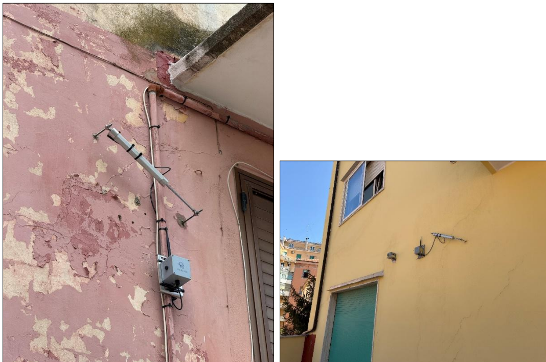
Figura 42 – Fessurimetri F05 e F06.
