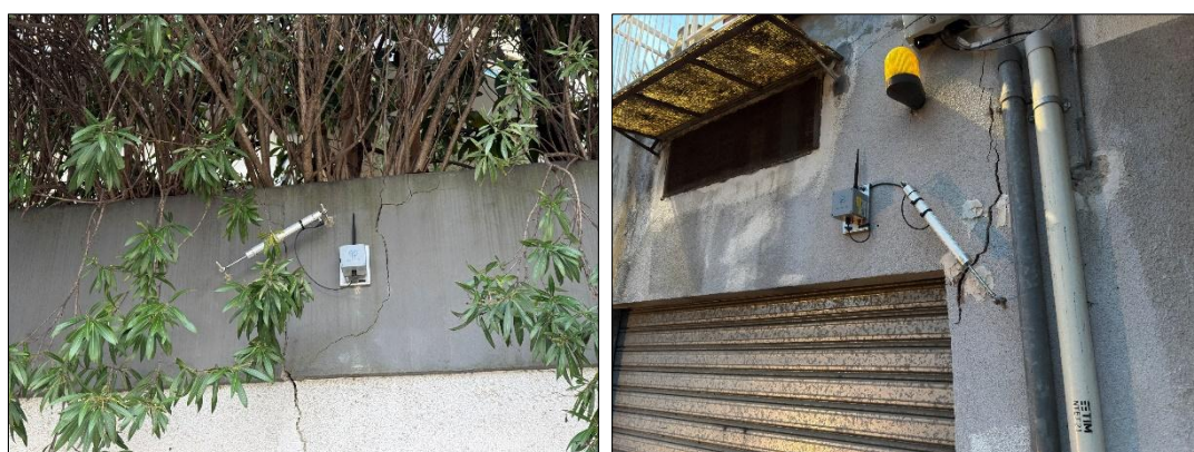
Figura 45 – Fessurimetri F11 e F12.
