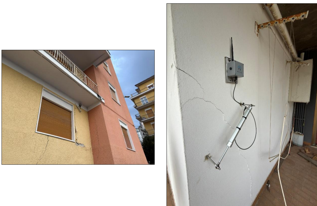
Figura 43 – Fessurimetri F07 e F08.
